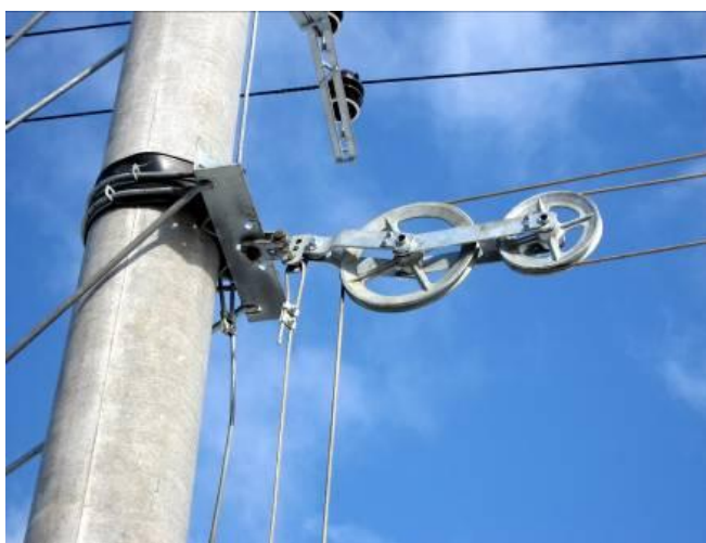
Рис. 4. Блочно-полиспастный компенсатор КБП-3-30
