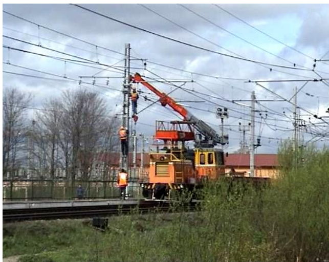
Рис. 2. Монтаж металлической опоры
