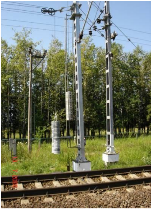
Рис. 1. Металлическая опора типа МКГА
